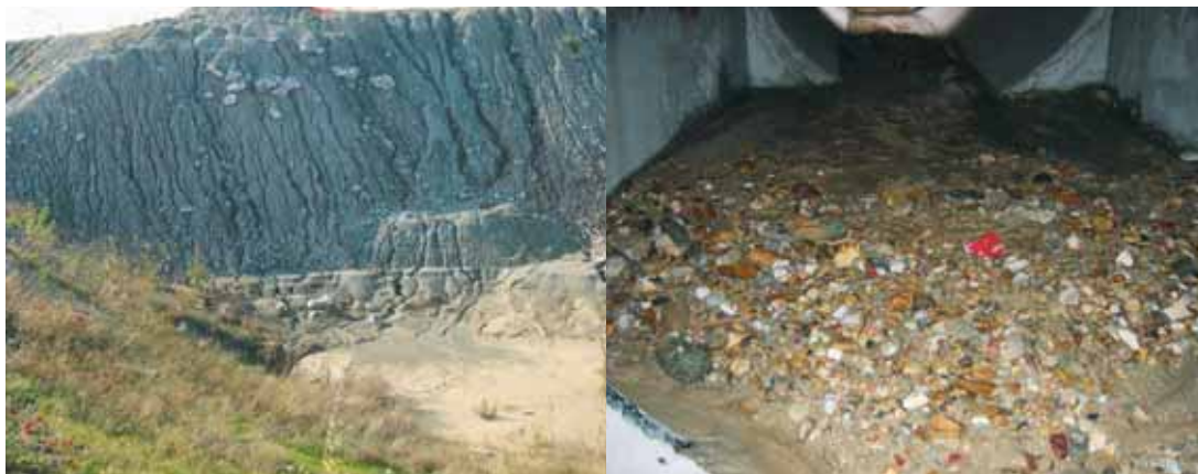
Las obras de explanación en el PAU de El Cañaveral y el nulo mantenimiento del drenaje transversal de la M-45 son causas de las inundaciones.
